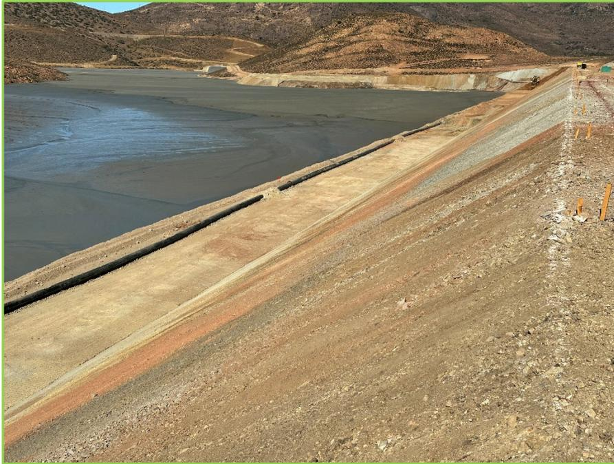
Fotografía 3: Muro Norte (MN) — Aguas Arriba. Corte y Retiro E5, Relleno Masivo.
