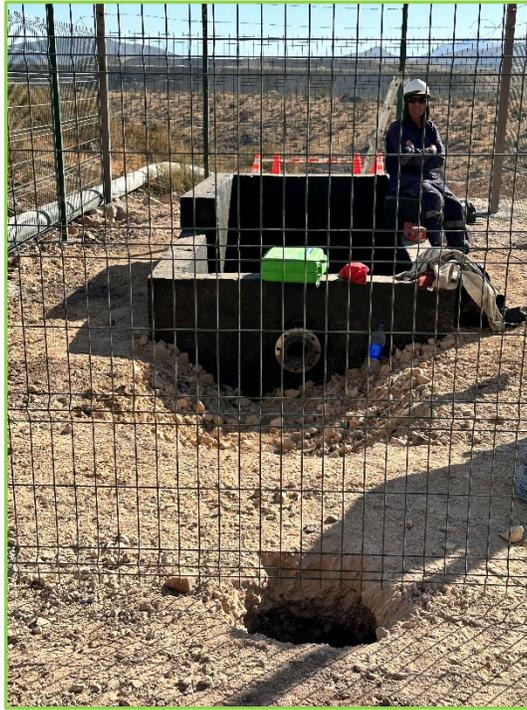
Fotografía 37: Muro MO(S) — Aguas Abajo. Aforador sistema de Drenaje.
