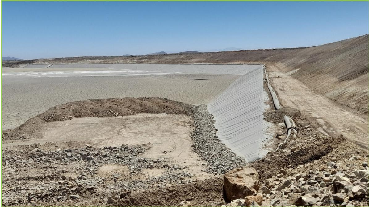
Fotografía 35: Muro MO(S) — Aguas Arriba. Talud Impermeabilizado, estribo sur, vista hacia el norte.
