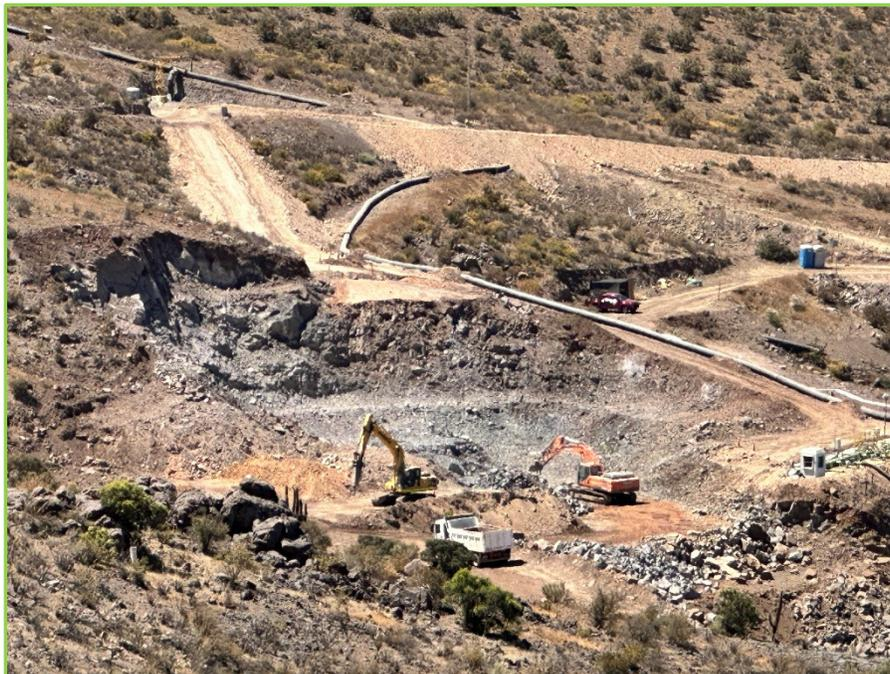
Fotografía 50: Trincheras — Trincheras # 10A. Excavación en roca y retiro de Marina.
