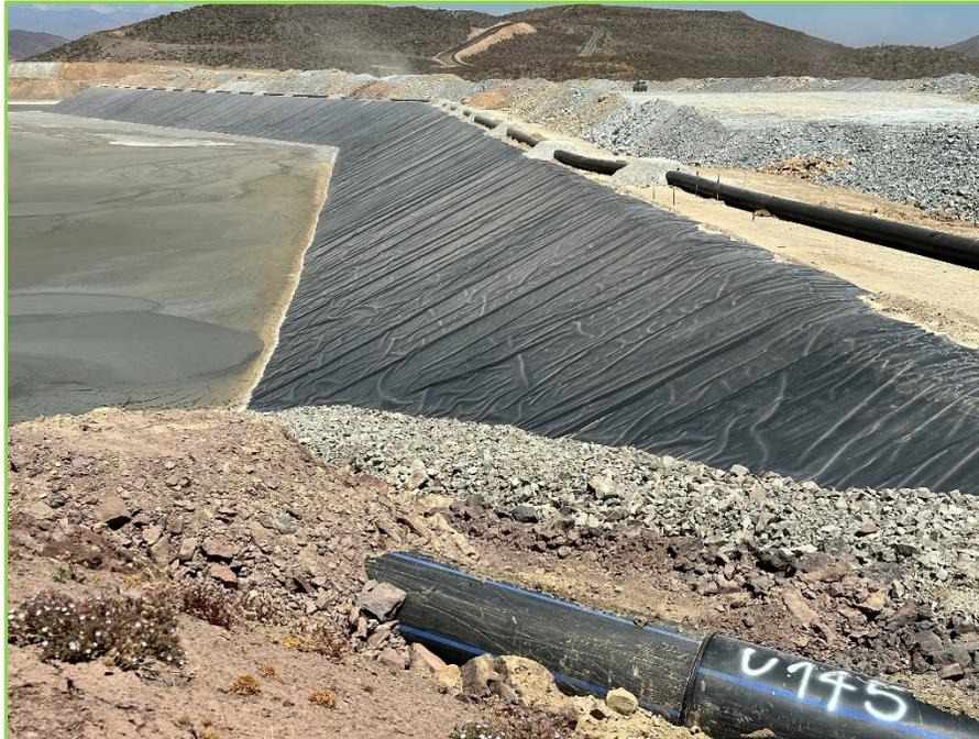
Fotografía 47: Muro MS — Aguas Arriba. Talud Impermeabilizado, estribo poniente, vista hacia el oriente.
