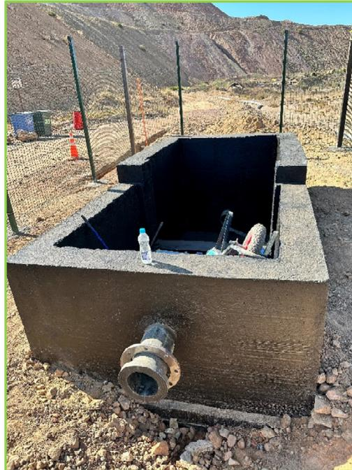
Fotografía 31: Muro MO — Aguas Abajo. Nuevo Aforador.
