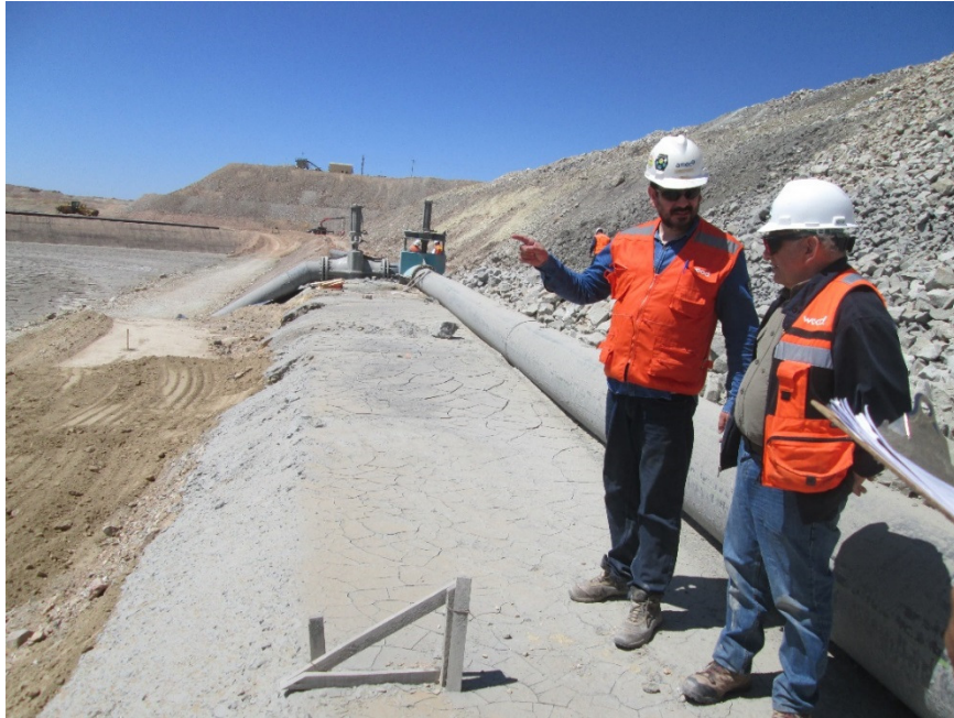
Fotografía 21: MO, Reparación de erosión talud aguas arriba – vista hacia el norte.
