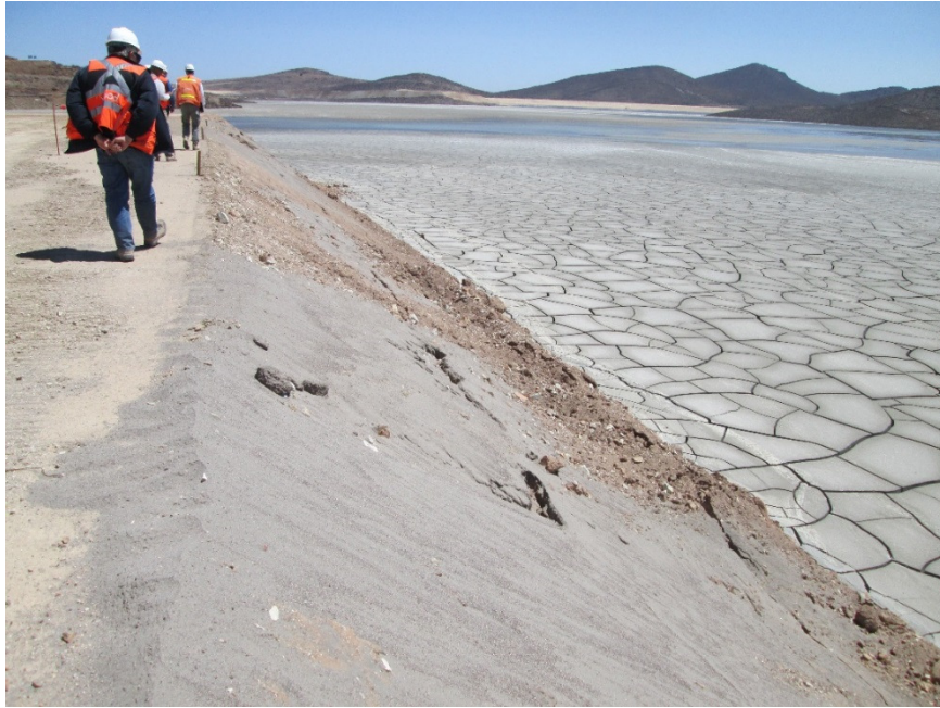
Fotografía 19: BS, Agrietamientos talud aguas arriba, sellado con arena fina / media
