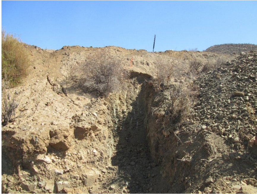
Fotografía 31: MP, Calicata exploración N°1 (norte).
