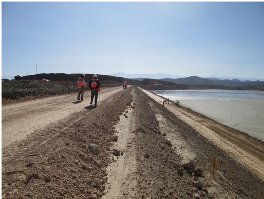
Fotografía 6: MN, coronamiento E4, – vista hacia el oriente.
