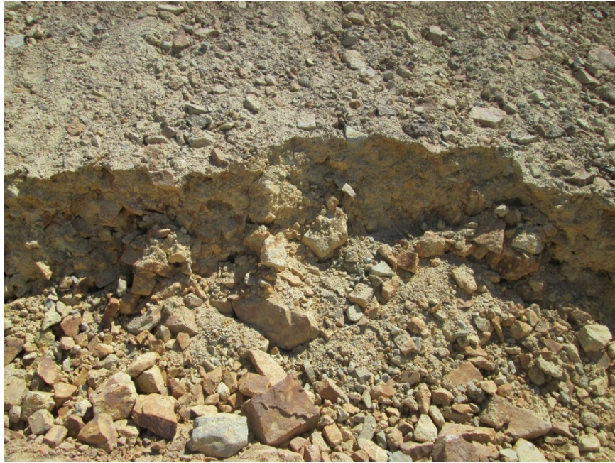
Fotografía 13: MNO, Talud E4, granulometría relleno masivo - detalle.
