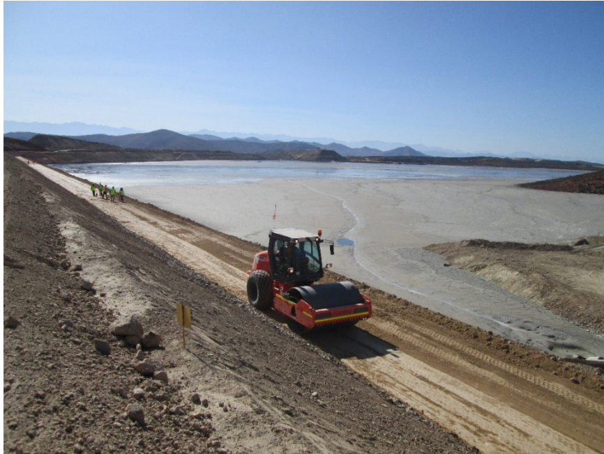
Fotografía 7: MN, construcción E4, compactación relleno de transición.
