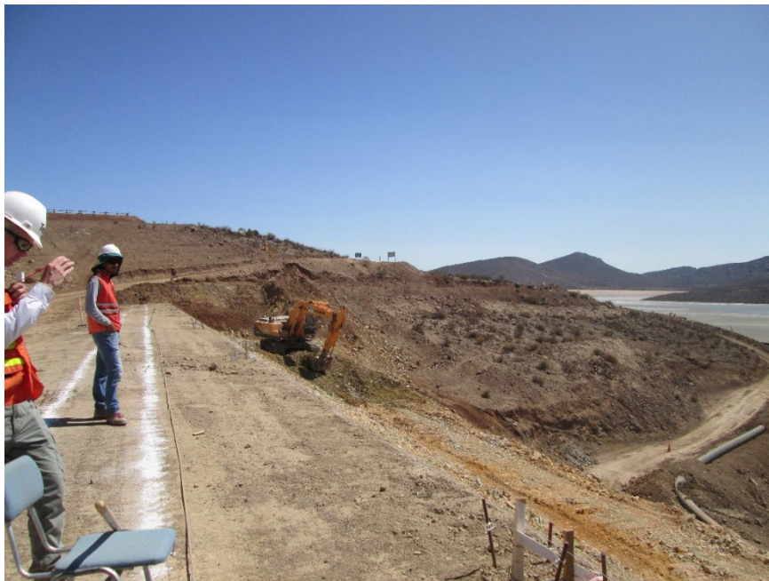
Fotografía 22: MO, Talud aguas arriba, estribo sur – vista hacia el sur.
