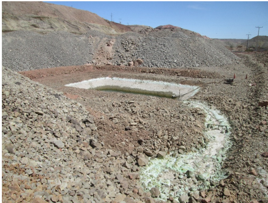
Fotografía 36 BS7MNO, Aguas Abajo – filtraciones (secas) y piscina colectora y de monitoreo
