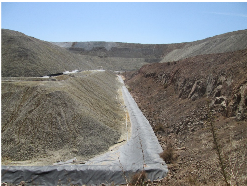
Fotografía 34: MO, Aguas Abajo, pilas de lixiviación – vista hacia el oriente.
