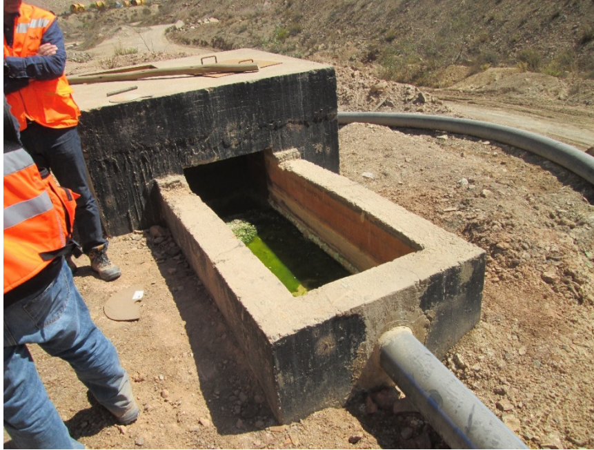
Fotografía 35: MO, Aguas Abajo, Aforador (V-Notch).
