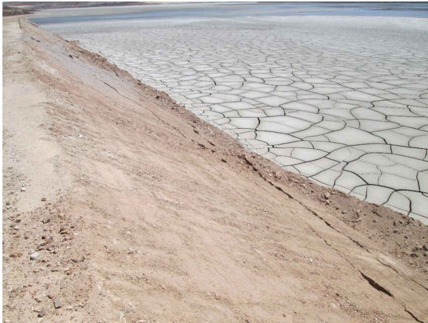
Fotografía 18: BS, Agrietamientos talud aguas arriba, relleno de transición.
