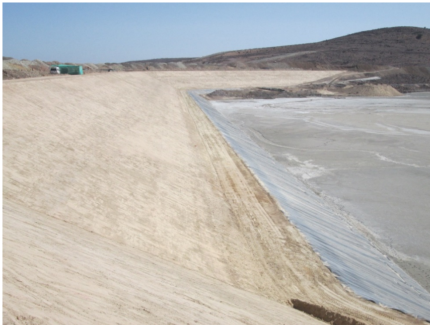
Fotografía 24: MO(S), Talud aguas arriba E4, relleno transición perfilado – vista hacia el sur.
