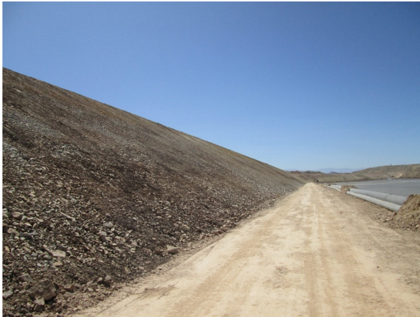
Fotografía 12: Plataforma E3, relleno masivo cortado– vista hacia el oriente.
