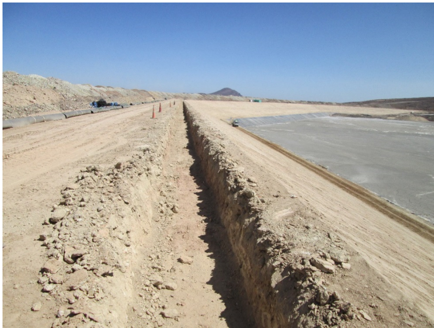
Fotografía 26: MO(S), Zanja de anclaje superior, para geosintéticos.
