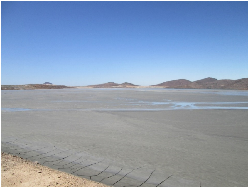
Fotografía 1: TMF, agua alejada de los muros – vista hacia el sur.
