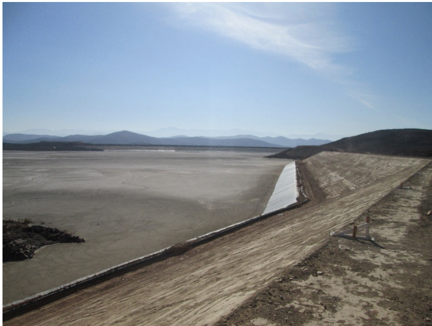
Fotografía 27: MS, Talud aguas arriba E4, relleno de transición perfilado – vista hacia el oriente.
