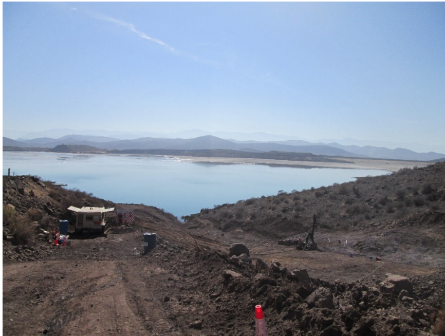
Fotografía 29: Construcción de trincheras N° 9 y N° 10, para recuperación de agua
