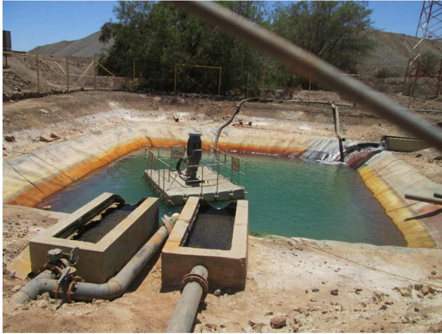
Fotografía 17: MNO, Piscina colectora de drenajes, aguas abajo.
