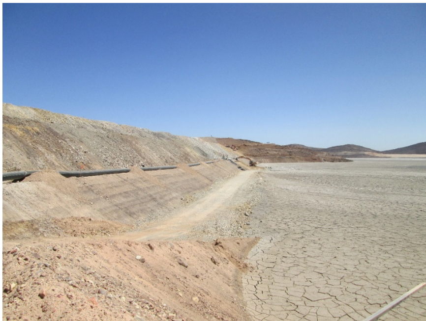
Fotografía 20: MO, Talud aguas arriba, plataforma acceso zona de reparación – vista hacia el sur.
