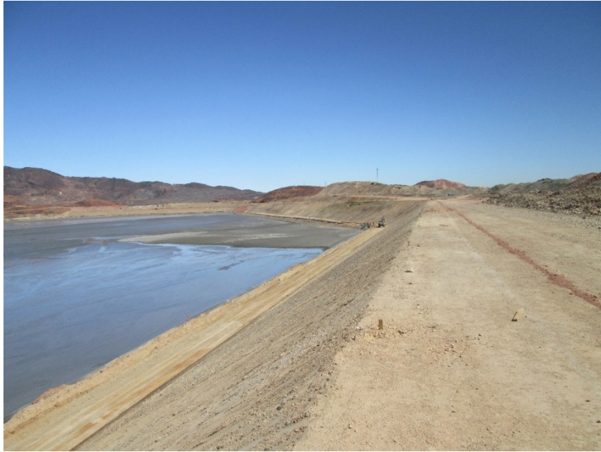
Fotografía 11: Talud aguas arriba E4, relleno masivo cortado– vista hacia el norte.
