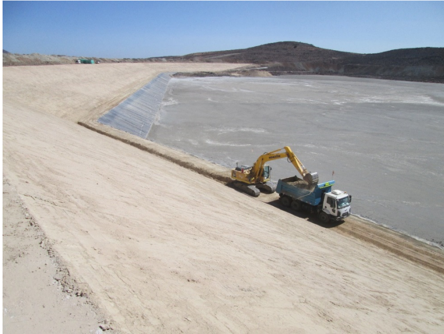
Fotografía 25: MO(S), Excavación zanja de anclaje inferior, para geosintéticos.
