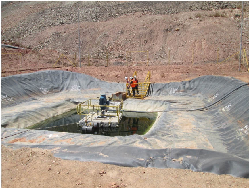
Fotografía 14: MN, Piscina colectora de drenajes aguas abajo.
