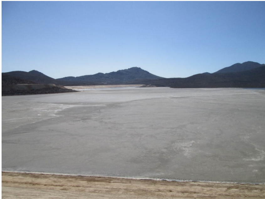
Fotografía 2: TMF, agua alejada de los muros – vista hacia el norte.
