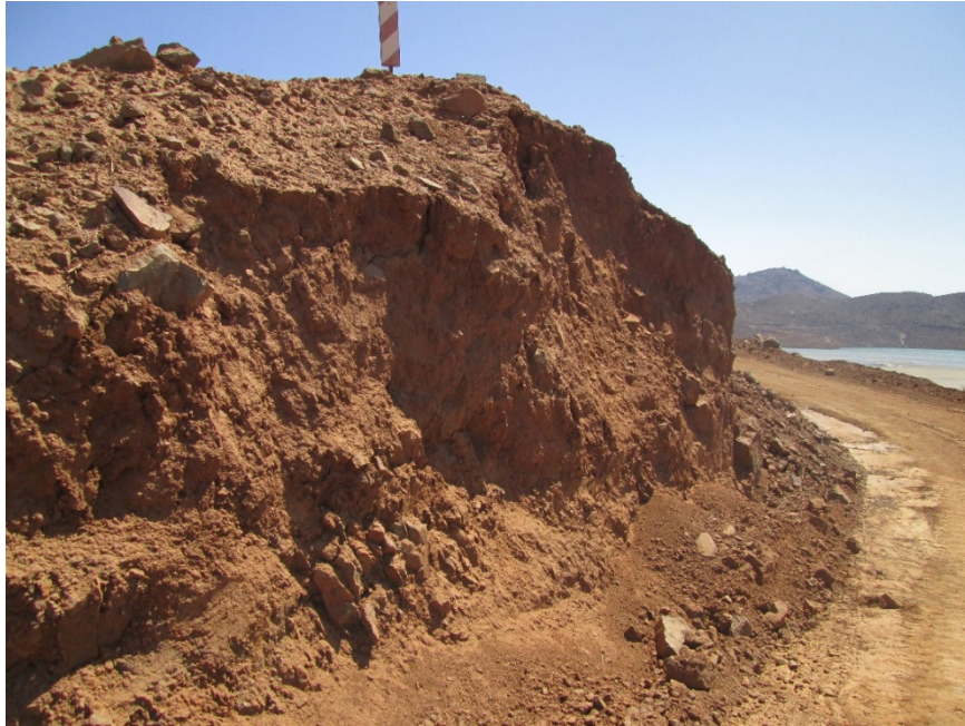
Fotografía 23: MO, Terreno natural, estribo sur – detalle.
