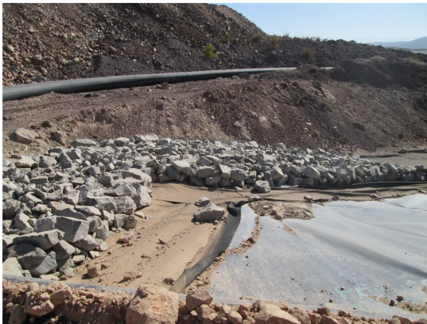
Fotografía 28: MS, Riprap, protección contra la erosión, zanja de anclaje lateral.
