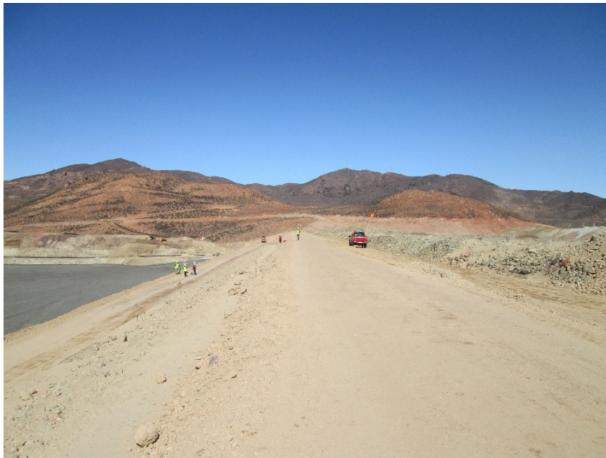
Fotografía 8: MN, coronamiento E4, El. 1.162,5 msnm – vista hacia el poniente.
