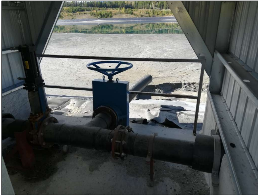
PHOTO 19 – E2 tailings discharge hut.
