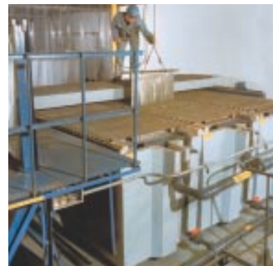
CESL Plant, Vancouver, B.C.
